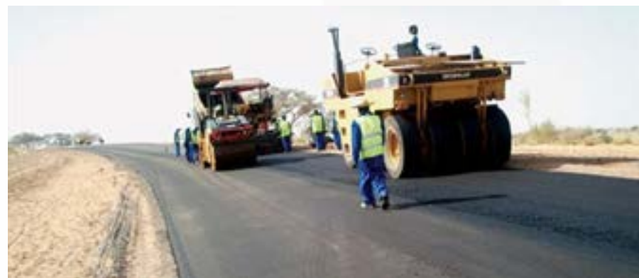
Construction et réhabilitation de routes en terre et bitumées
